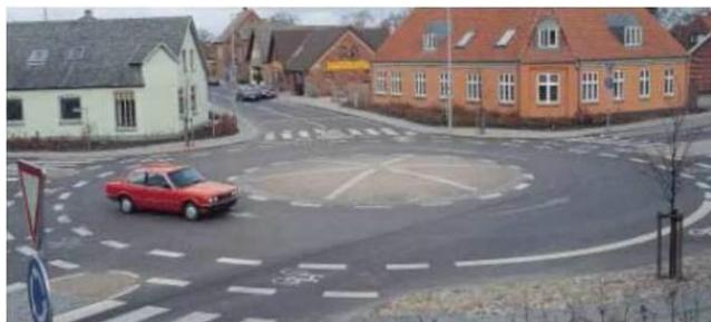
Slika 3.42. Vođenje biciklista unutar kružnoga raskrižja
