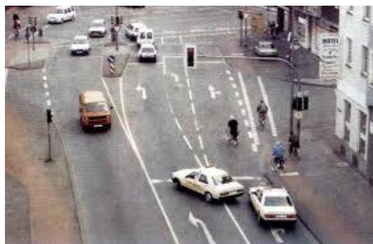
Slika 3.34. Izravno skretanje s biciklističke staze prethodnim uvođenjem biciklista na kolnik
