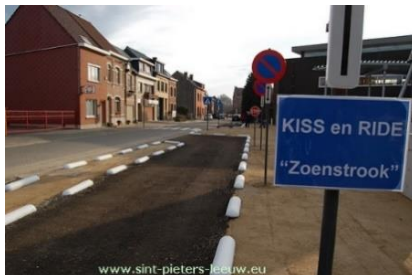
Slika 41. Izgradnja Kiss + Ride parkirališta [37]
