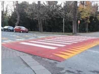
Slika 45. Vertikalno izdizanje pješačkoga prijelaza
