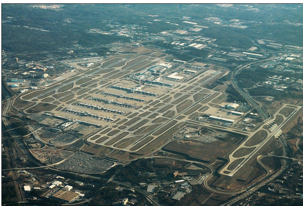
Slika 8.5. Dvostruke paralelne uzletno-sletne staze, Hartsfield-Jackson-Atlanta-International-Airport, USA [76]
