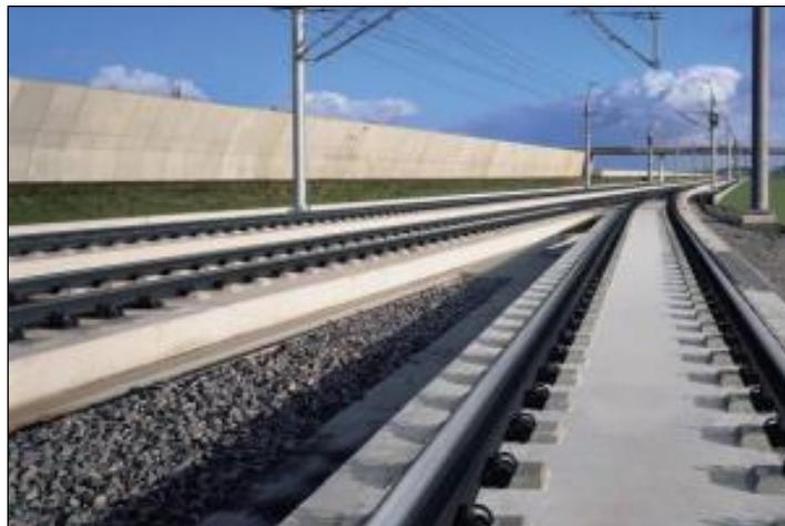
Slika 5.13. Kolosijek na čvrstoj podlozi (bez zastora) [39]
